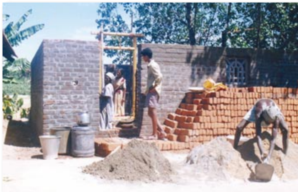
Construction de la maison familiale de Vikram à Pondichéry (2001)
